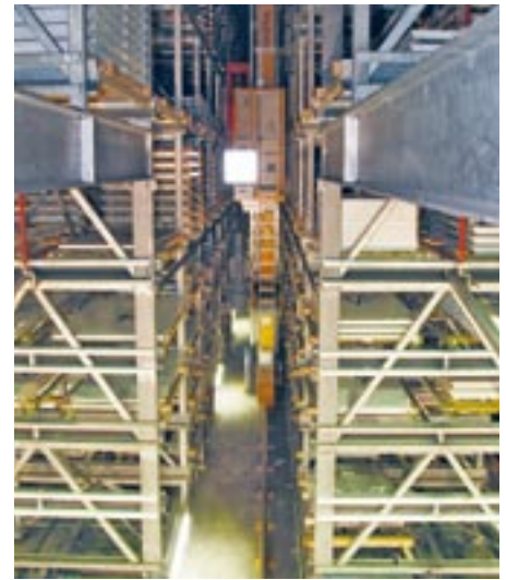
Im fünf-gassigen Hochregallager in Silobauweise werden die Fertigteile zwischen-gelagert.
